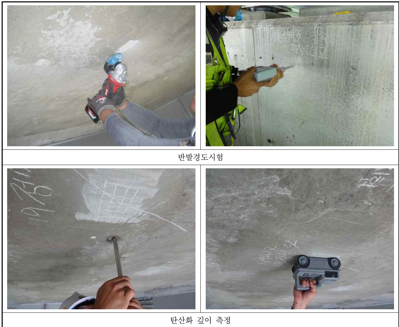
【사진 3.25】 콘크리트 내구성조사 현황
