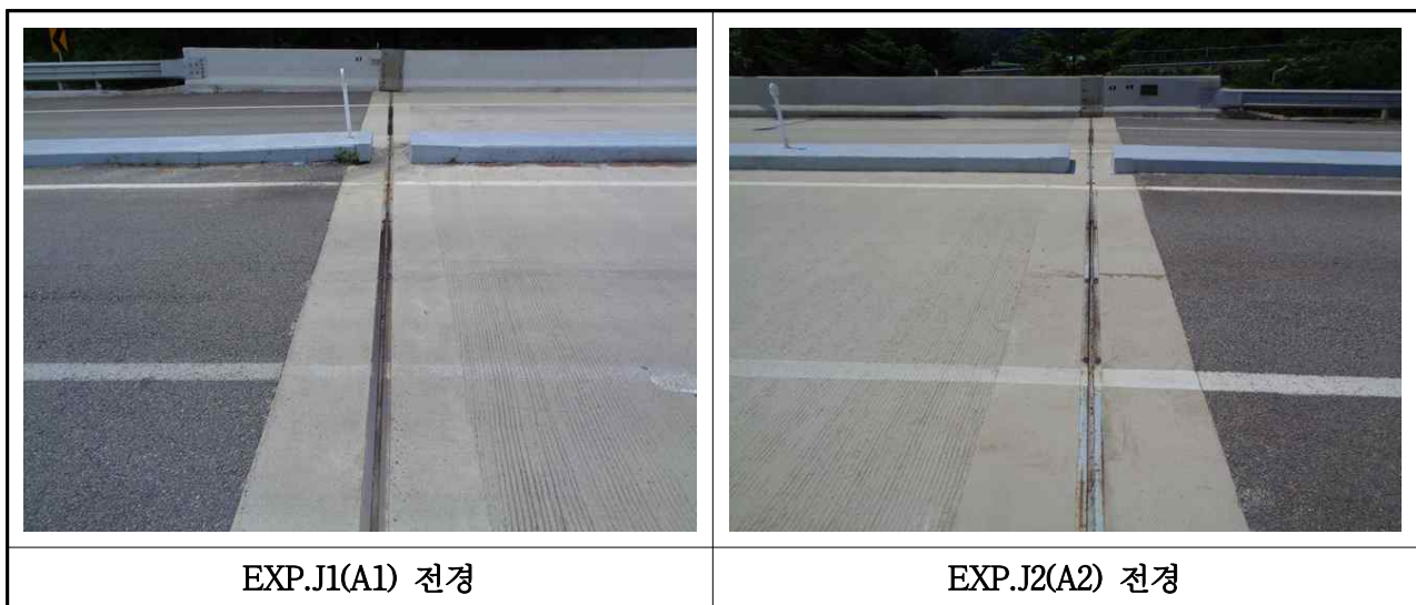
【사진 3.17】 신축이음장치 전경
