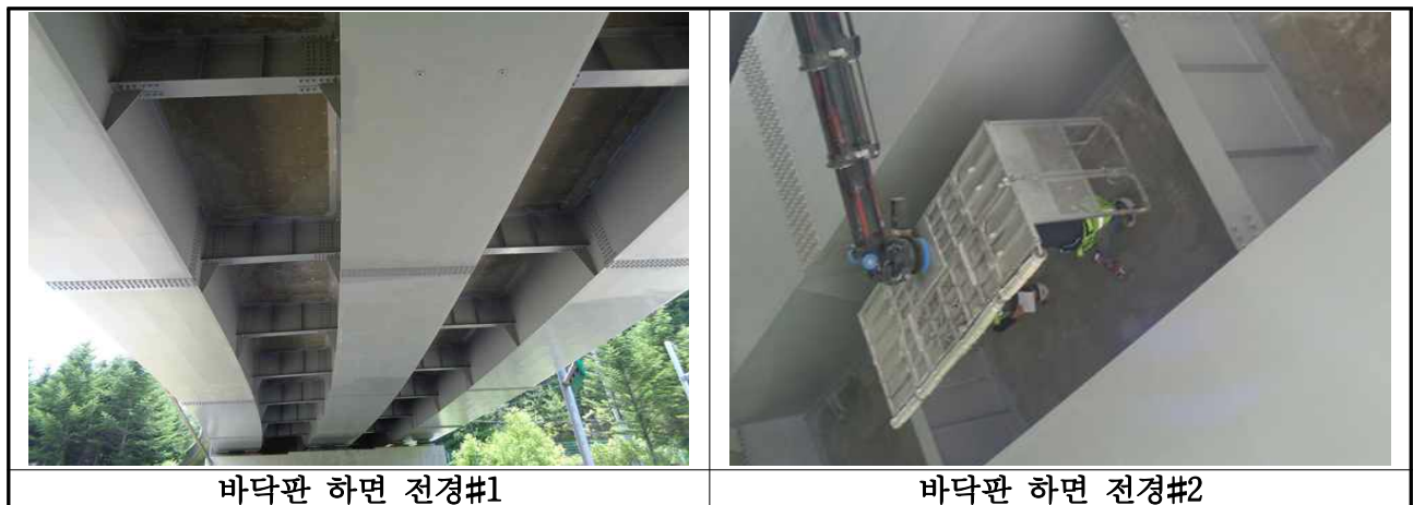
【사진 3.2】바닥판 전경
