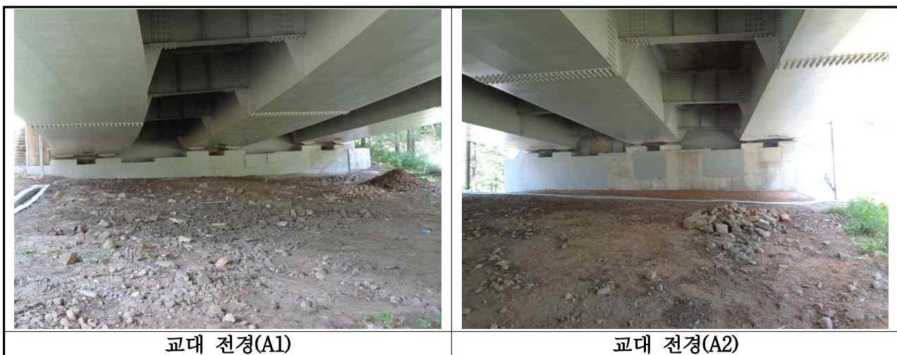
【사진 3.9】 교대 전경
