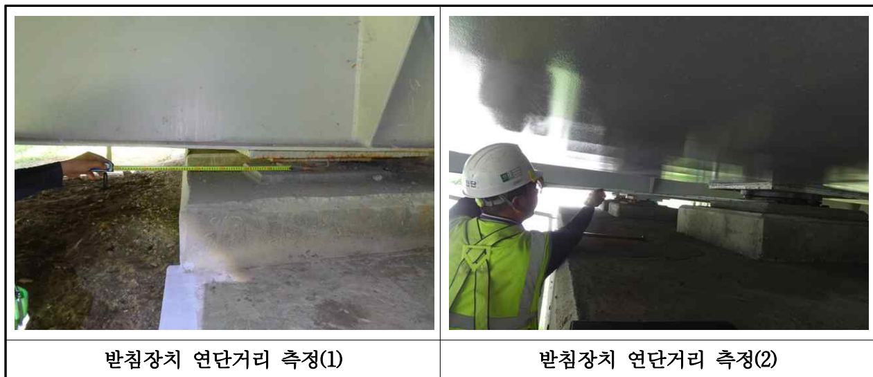
【사진 3.15】 교량받침장치 연단거리측정
