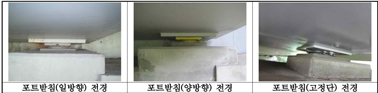
【사진 3.13】 교량받침 전경
