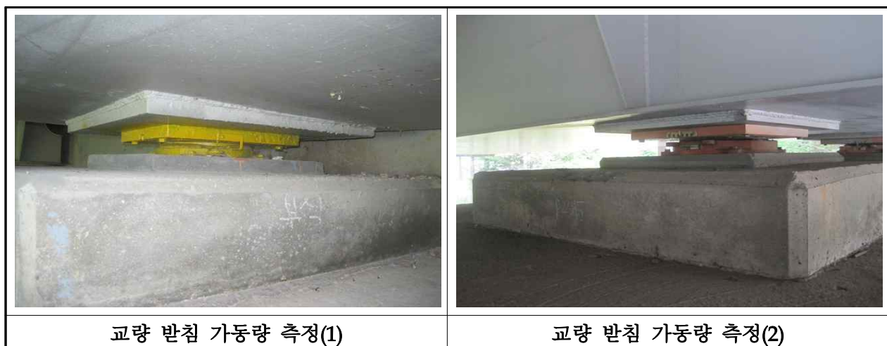
【사진 3.16】교량받침 이동량 측정
